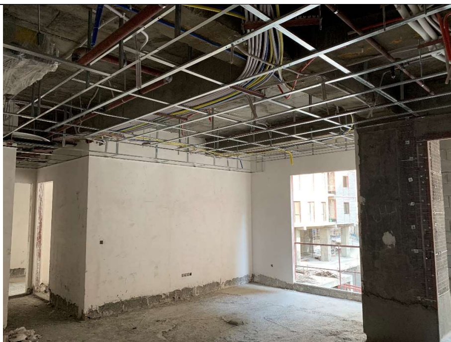
اجرای شاسی سقف کاذب طبقه اول در بلوک C
