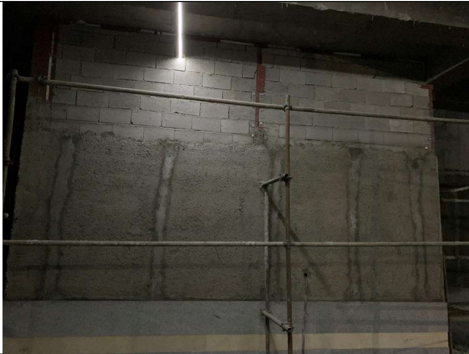
اجرای سیمانکاری دیوارهای پارکینگ طبقه ۵-
