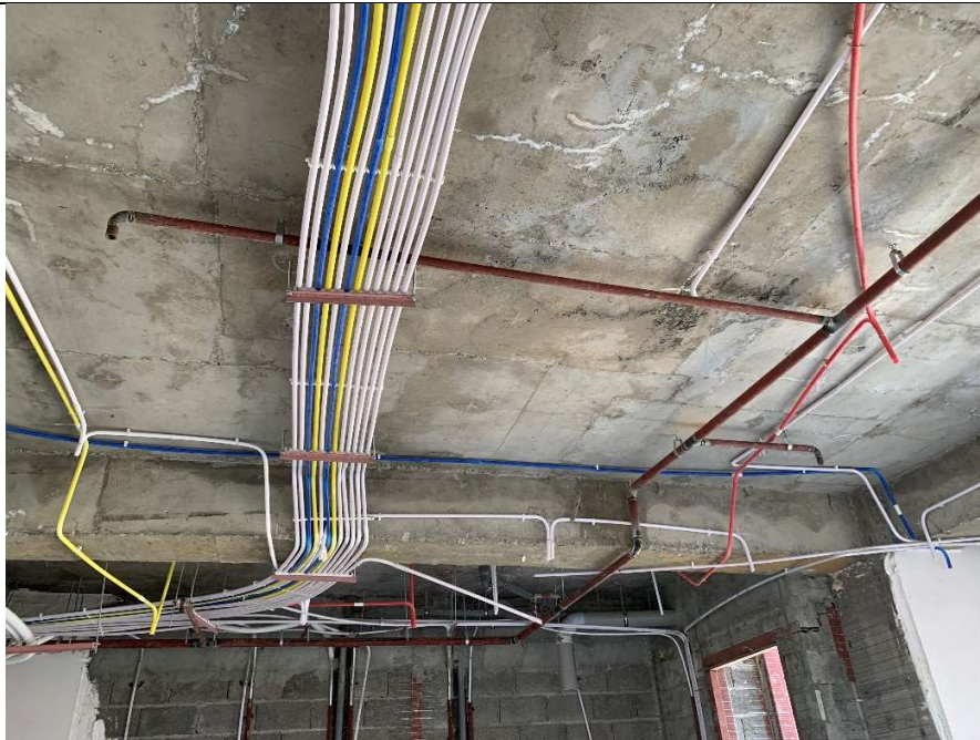
اجرای لوله کشی آتشنشانی (اسپرینگر) طبقات اول الی پنجم بلوک C
