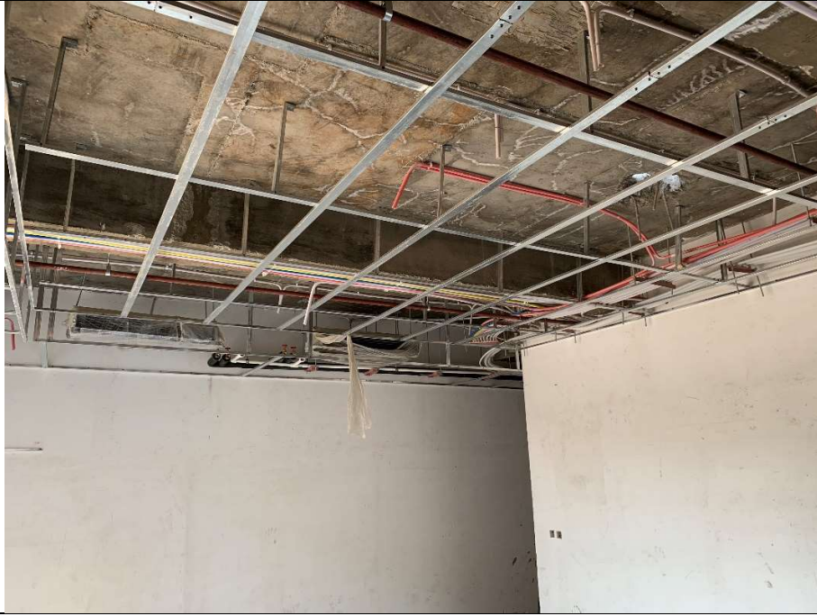
اجرای شاسی سقف کاذب طبقه سوم بلوک B
