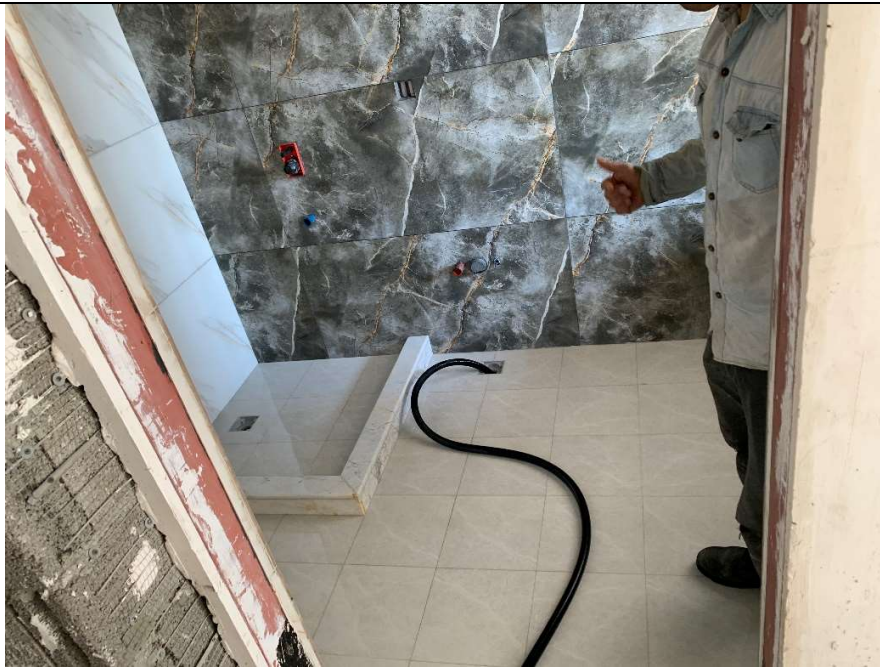
اجرای کاشی و سرامیک سرویس ها از طبقه اول الی ششم بلوک B
