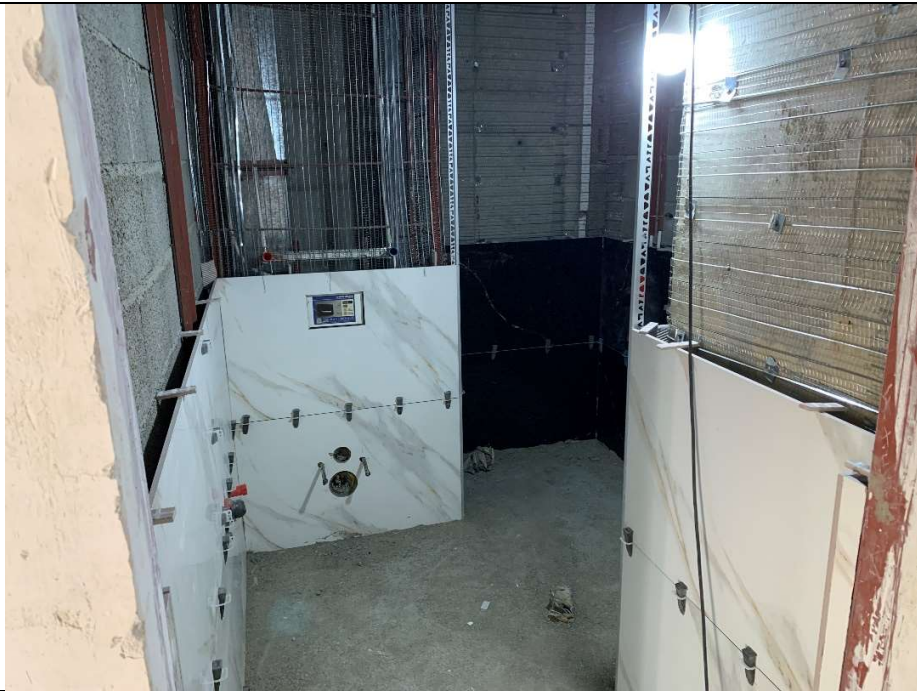
اجرای کاشی کاری سرویس ها طبقه هفتم
