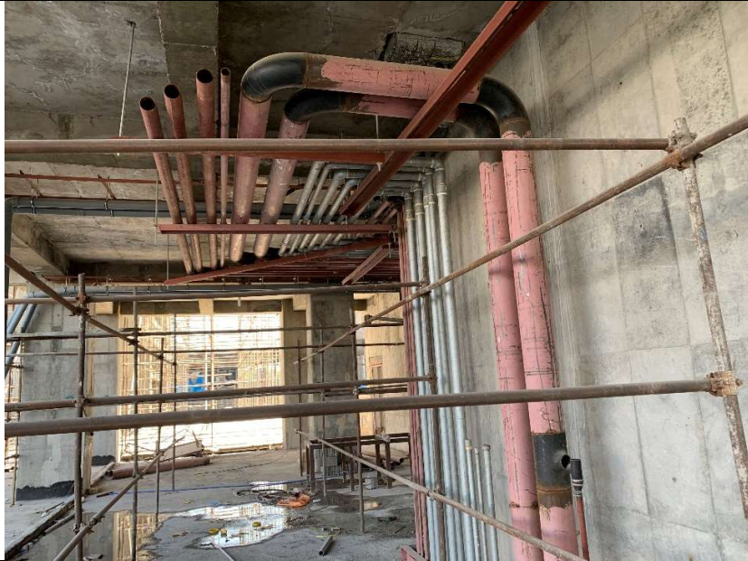
اجرای لوله های رایزر در طبقه همکف
