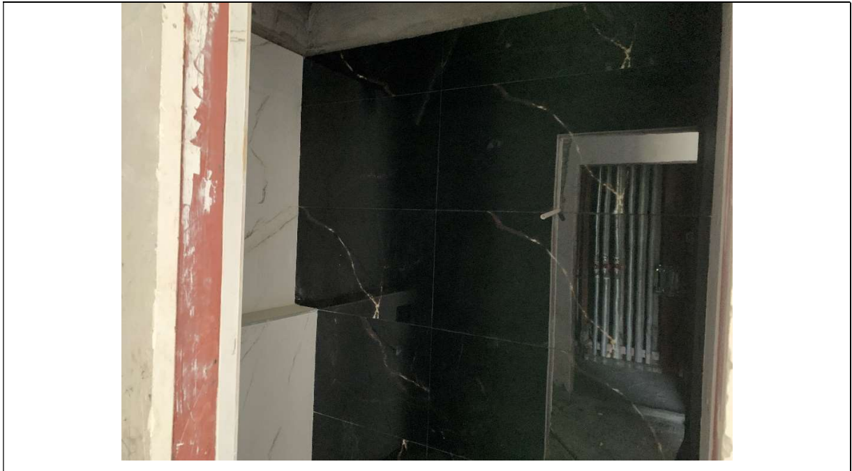
کاشی کاری بلوک C
