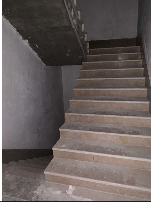
اتمام اجرای سنگ پله در ۴ دستگاه پله هر دو بلوک
