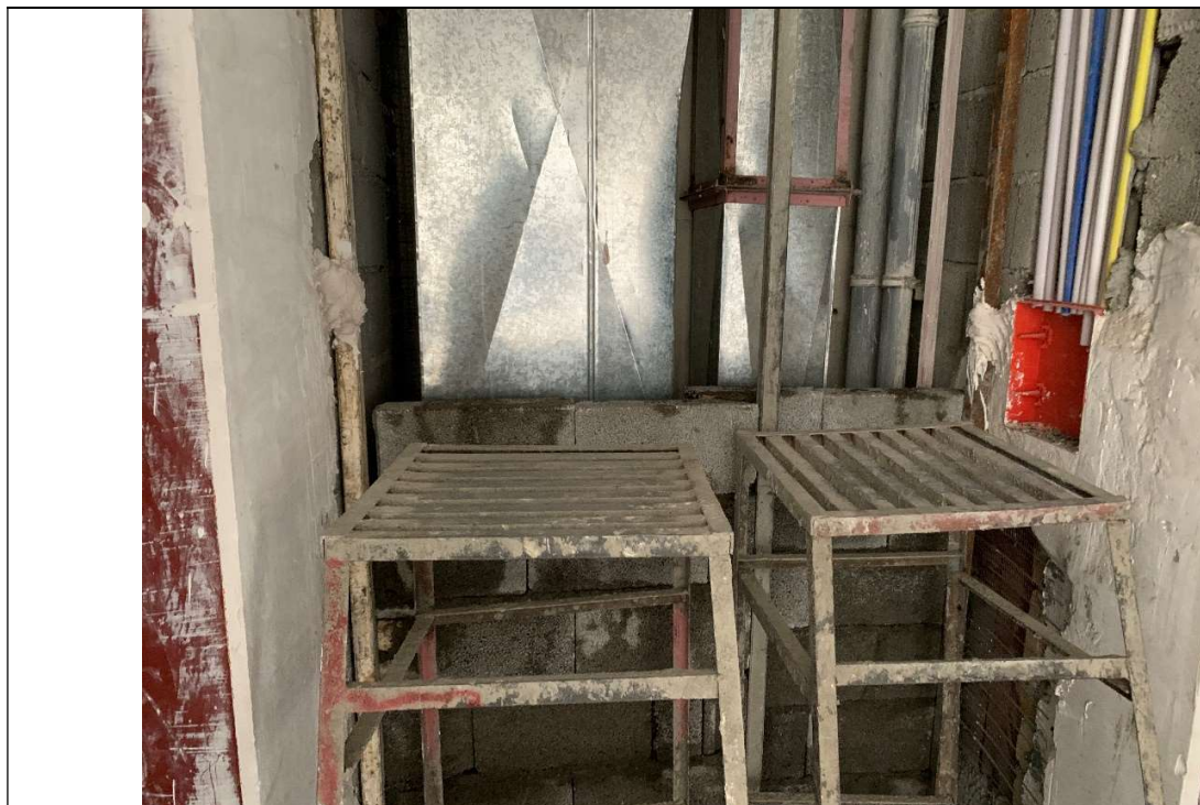
اتمام کار داکت های تاسیساتی و تیغه چینی روی آن طبقه دهم
