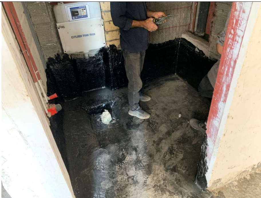
ایزولاسیون سرویس ها طبقه هشتم
