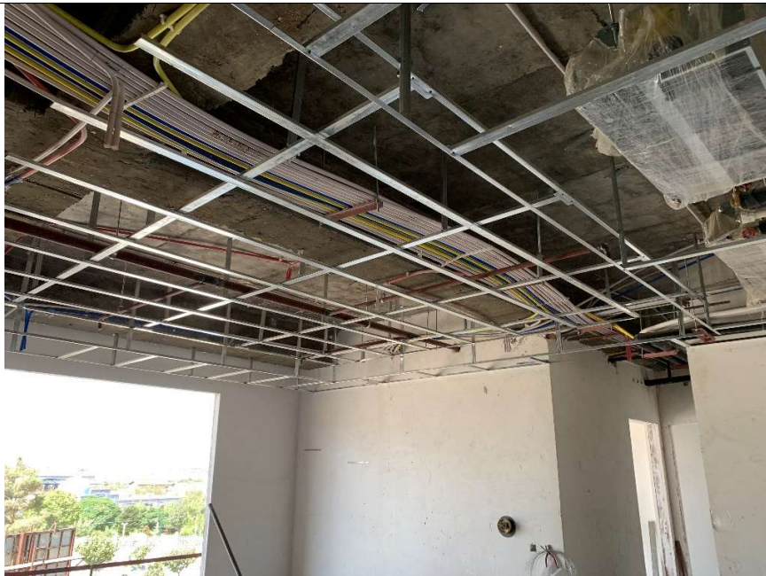
اجرای شاسی سقف کاذب بلوک C
