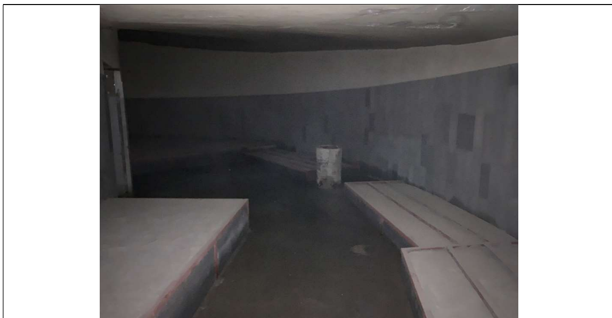
سنگ کاری و سیمانکاری دیوارها و اجرای فونداسیون پمپ ها و مخازن آتشنشانی و تامین آب
