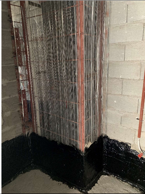
ایزولاسیون سرویس ها به همراه لایه محافظ روی آن طبقه هشتم
