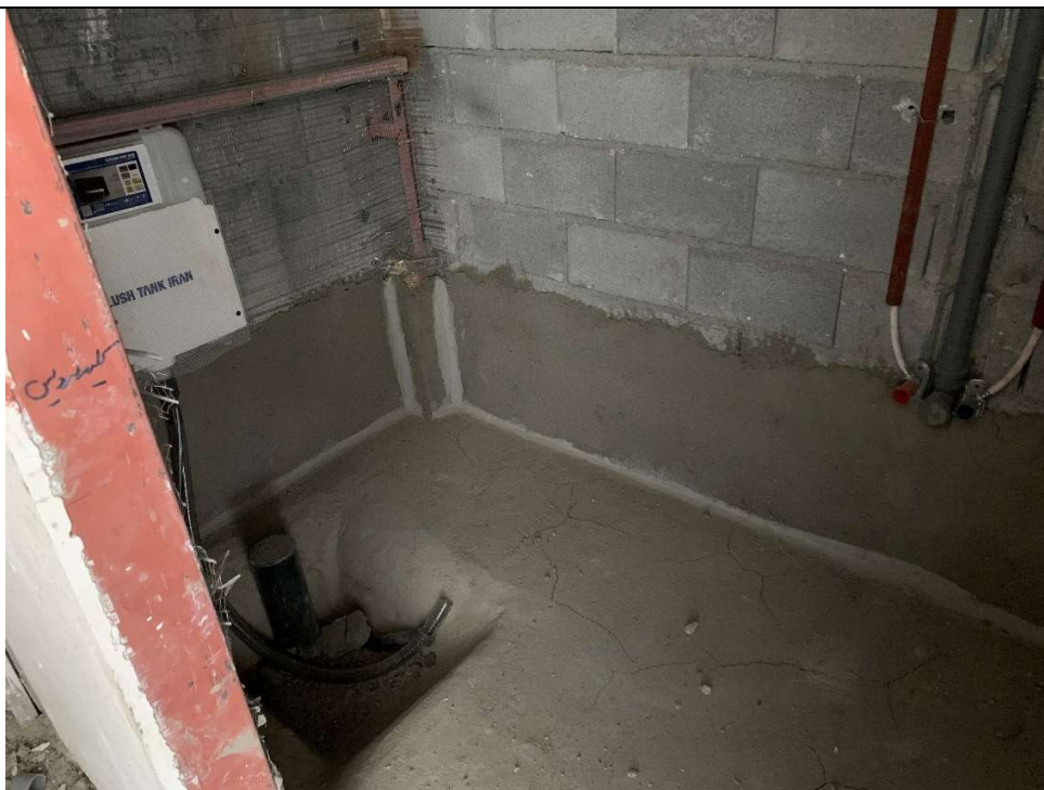
سیمانکاری کف سرویس ها جهت ایزولاسیون طبقه دوم بلوک C
