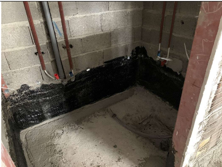
اجرای ایزولاسیون و لایه محافظ آن در بلوک C
