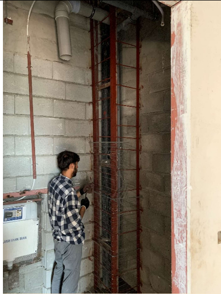
اجرای شاسی کشی روی رایزر لوله ها جهت آماده سازی کاشی کاری طبقه نهم بلوک B
