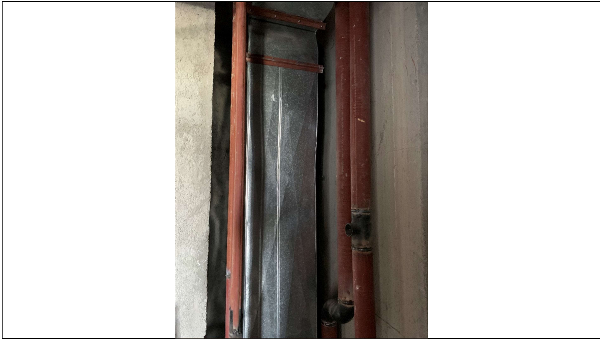
اجرای کانال فشار مثبت طبقات اول الی پانزدهم بلوک C
