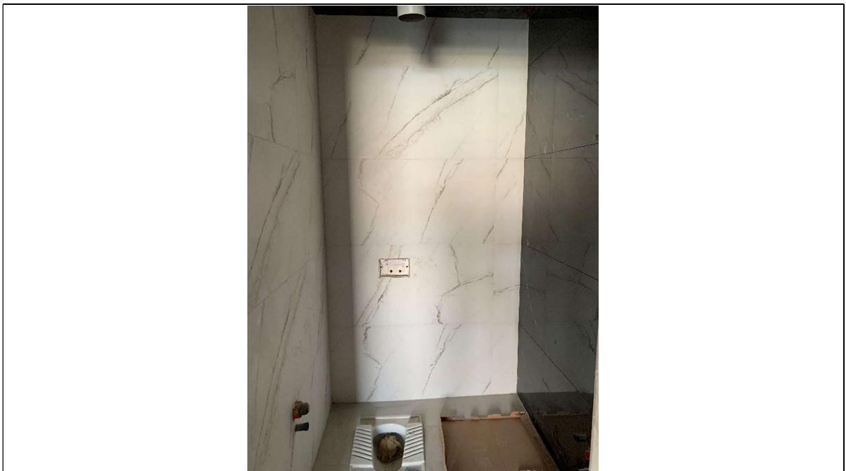
کاشی کاری بلوک C
