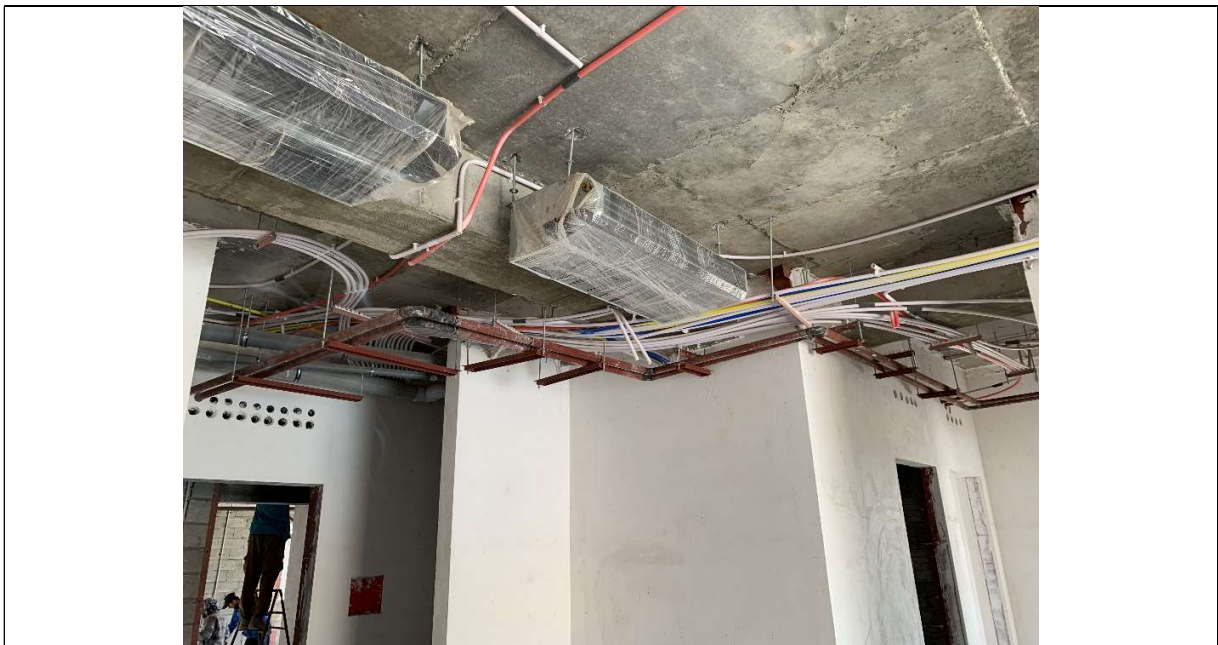
اجرای لوله کشی سرمایش-گرمایش و نصب فن کویل طبقه یازدهم
