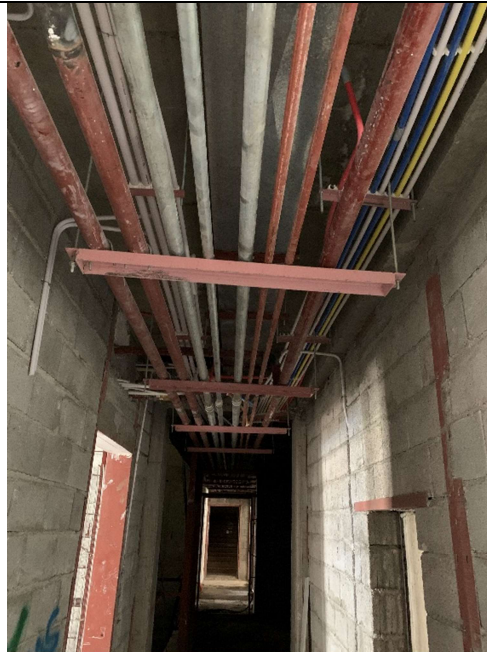
اجرای لوله های مشاعات (راهرو طبقات) و کانال فشار مثبت از طبقه اول الی دهم هر دو بلوک
