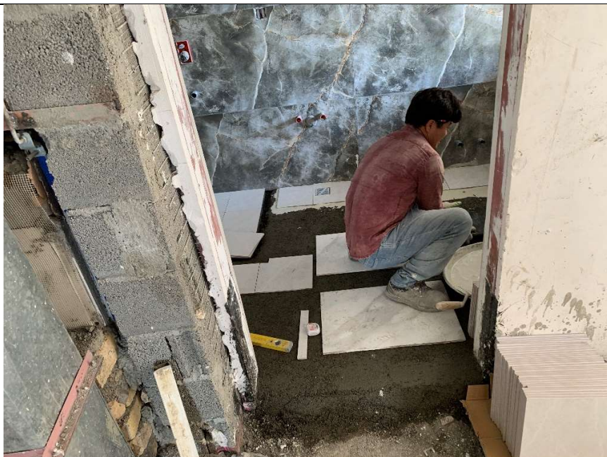
اجرای سرامیک کف سرویس ها طبقه هفتم
