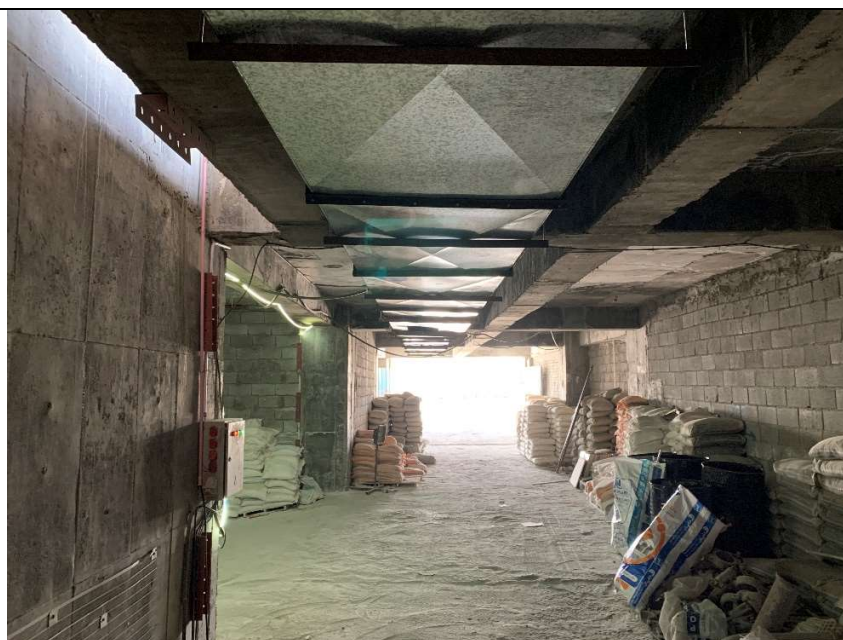
اجرای کانال تخلیه دود و هوای تازه پارکینگ ۱-
