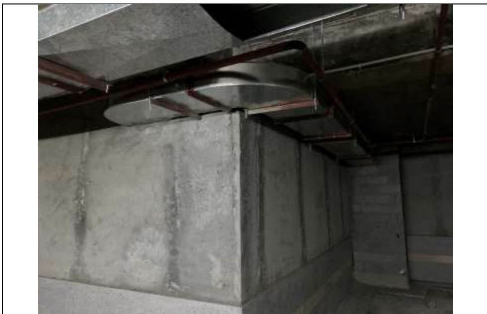
موضوع کاری: اجرای کانال فشار مثبت راه پله در طبقات زیر زمین
