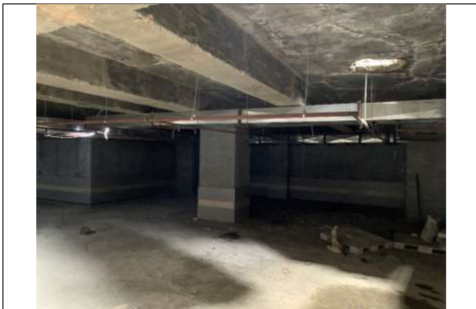
موضوع کاری: سیمان کاری زیر کار دیوار پارکینگ در طبقه 2-
