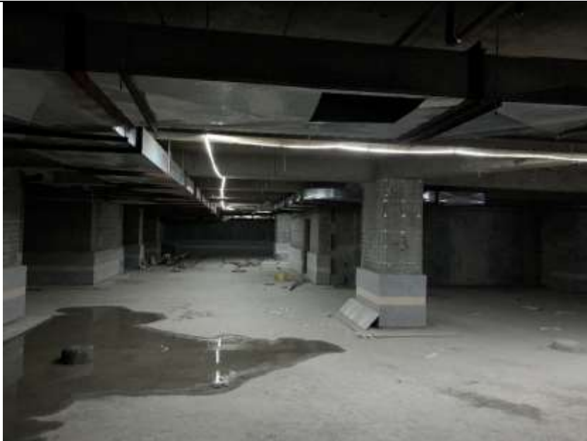
موضوع کاری: نصب کانال ها در طبقه 3-
