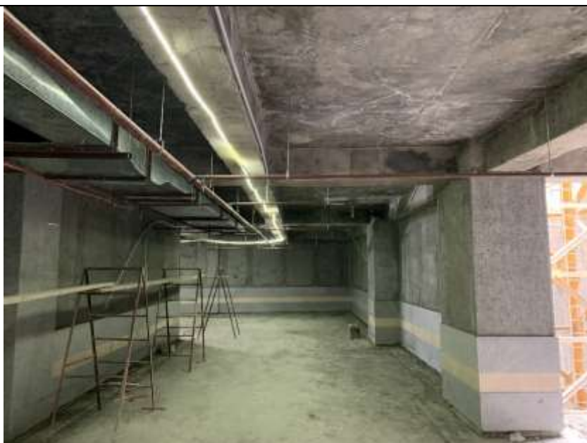
موضوع کاری: اجرای لوله اسپرینگلر ، کانال و سیمانکاری در طبقه 2-
