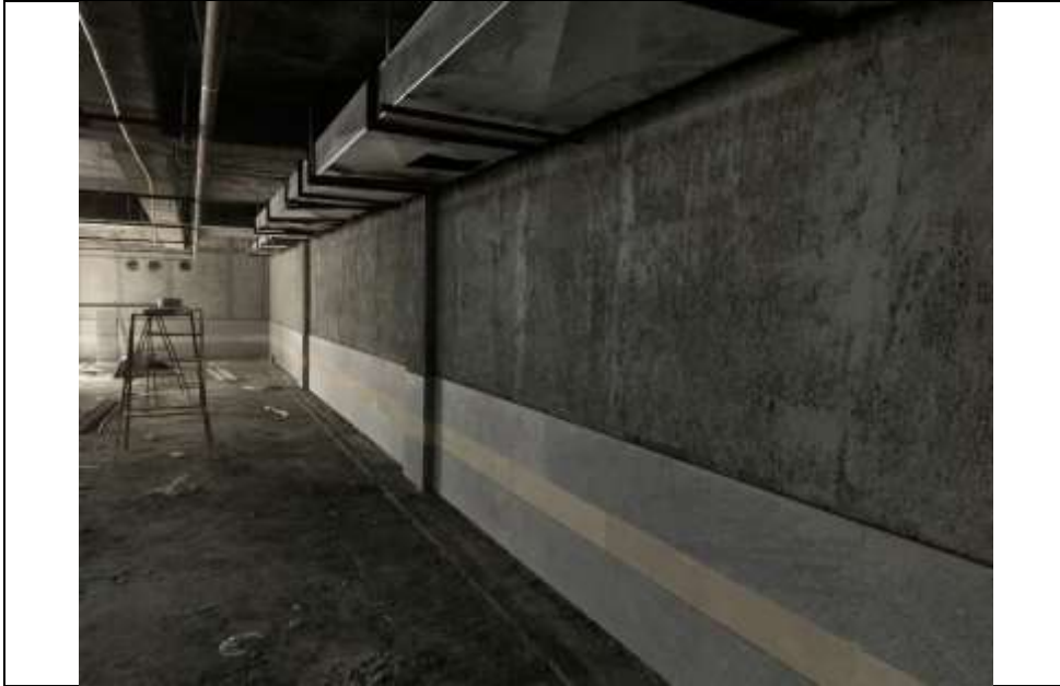
موضوع کاری: سیمانکاری زیر کار دیوار پارکینگ
