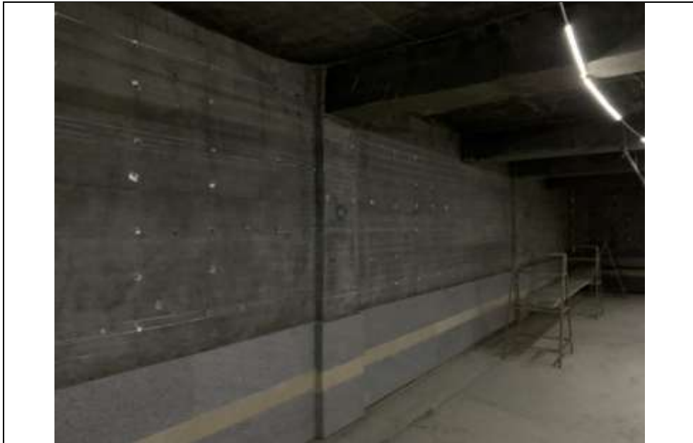
موضوع کاری: اجرای توری رابیتس در طبقات زیر زمین
