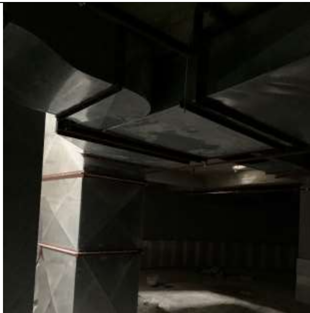
موضوع کاری: رایزر کانال نصب شده در طبقات زیر زمین
