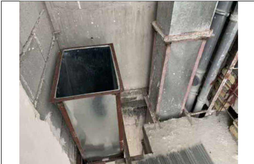
موضوع کاری: اجرای رایزر فشار مثبت راه پله در طبقات
