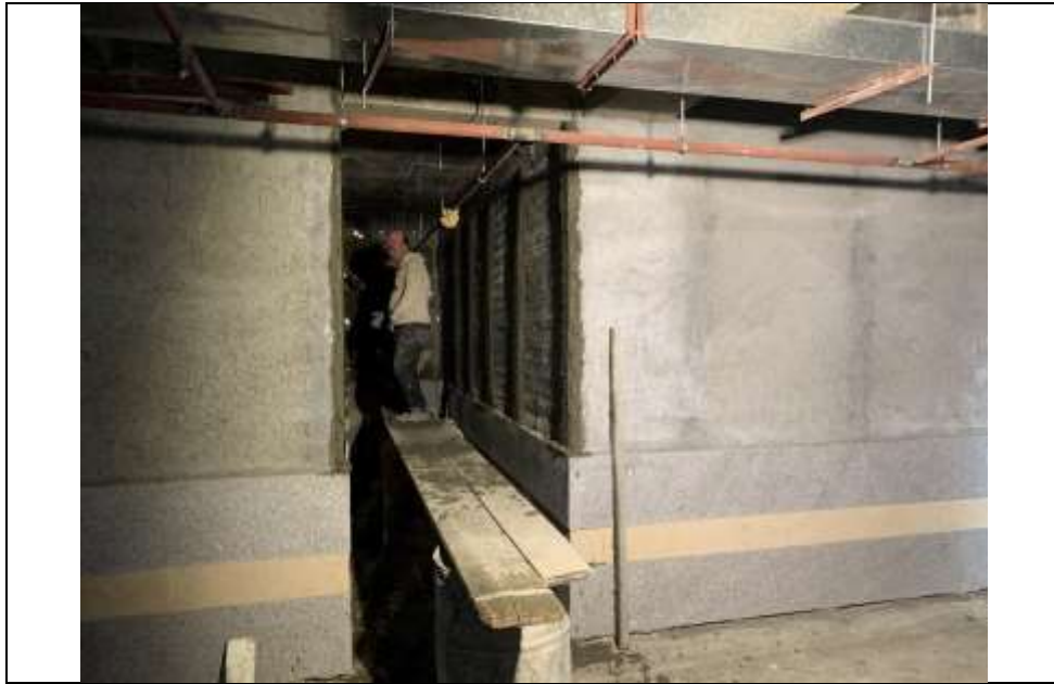
موضوع کاری: سیمانکاری طبقه 3-
