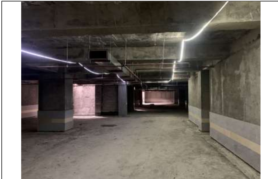
موضوع کاری: سیمانکاری دیواره پارکینگ
