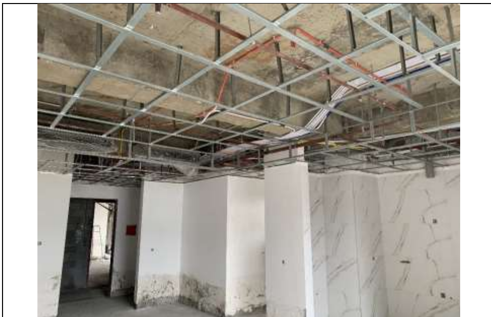
موضوع کاری: اجرای سازه سقف کاذب طبقه اول بلوک B
