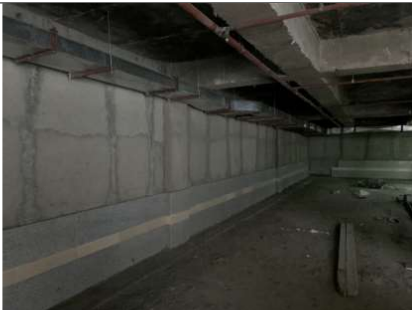
موضوع کاری: سیمانکاری زیر کار دیوار پارکینگ
