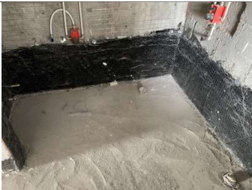
موضوع کاری: اجرای لایه محافظ بر روی ایزولاسیون کف و توری مرغی جهت چسبندگی بهتر کاشی بدنه
