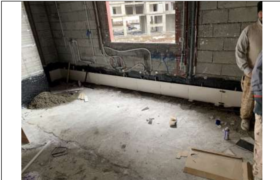
موضوع کاری: اجرای کاشی پشت کابینتی در طبقه اول بلوک B
