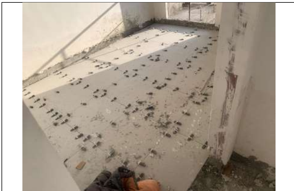
موضوع کاری: اجرای سرامیک کف اتاق خواب ها جهت زیر سازی کفپوش در طبقه اول بلوک B
