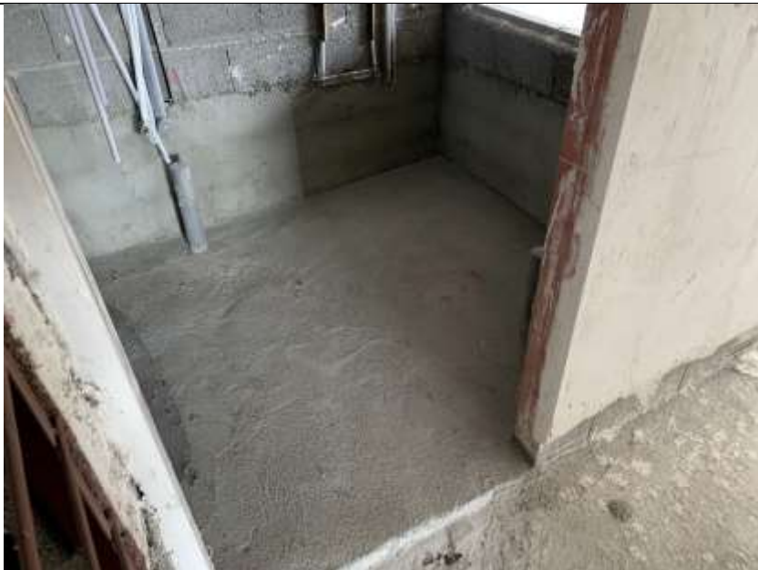
موضوع کاری: سیمان کاری (زیر سازی عایق) در طبقه اول بلوک B
