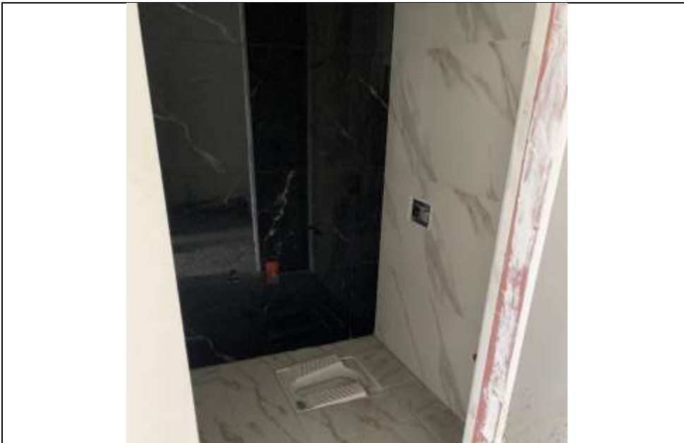
موضوع کاری: اجرای کاشی دیوار و کف سرویس
