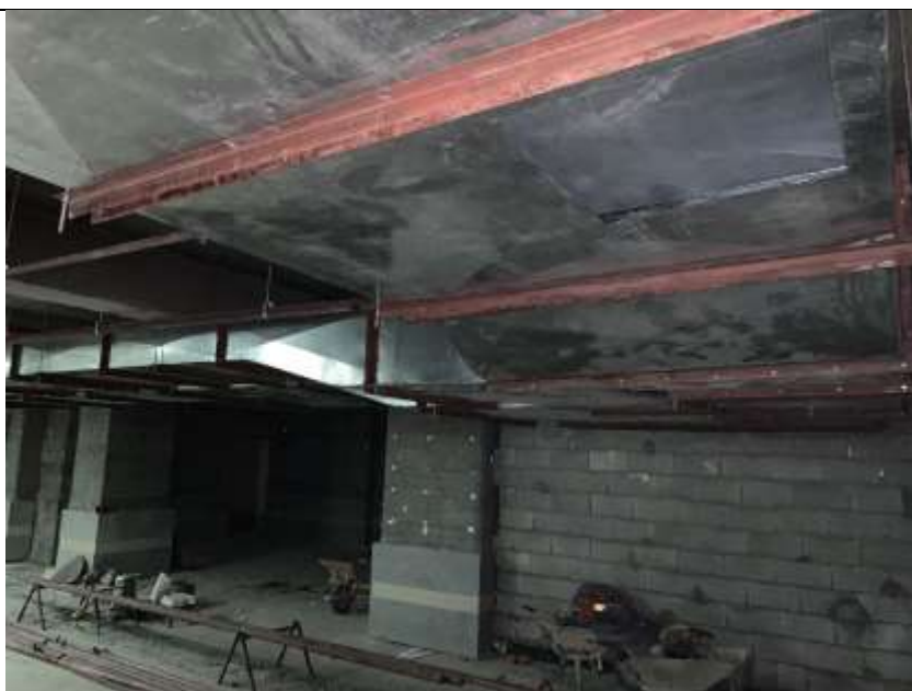
موضوع کاری: تیغه چینی و هوابندی داکت های تاسیساتی در زیر زمین ها
