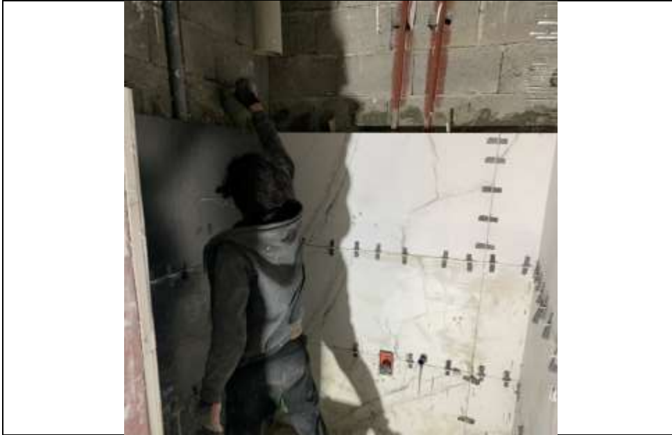
موضوع کاری: اجرای کاشی در طبقه اول بلوک B
