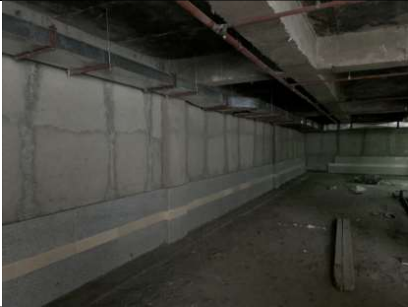
موضوع کاری: سیمانکاری زیر کار دیوار پارکینگ
