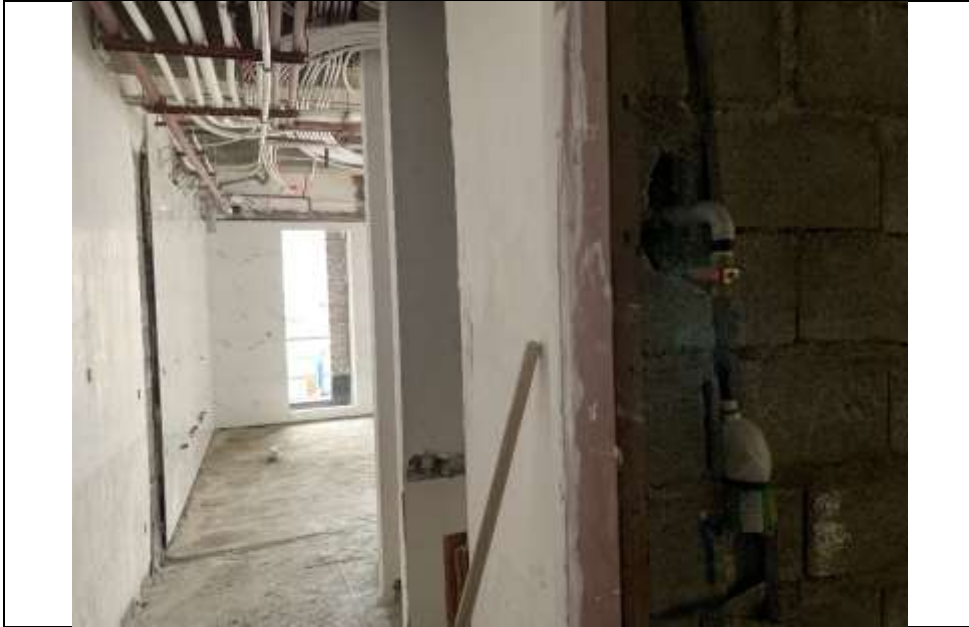
موضوع کاری: لوله کشی گاز رسانی طبقه اول بلوک B
