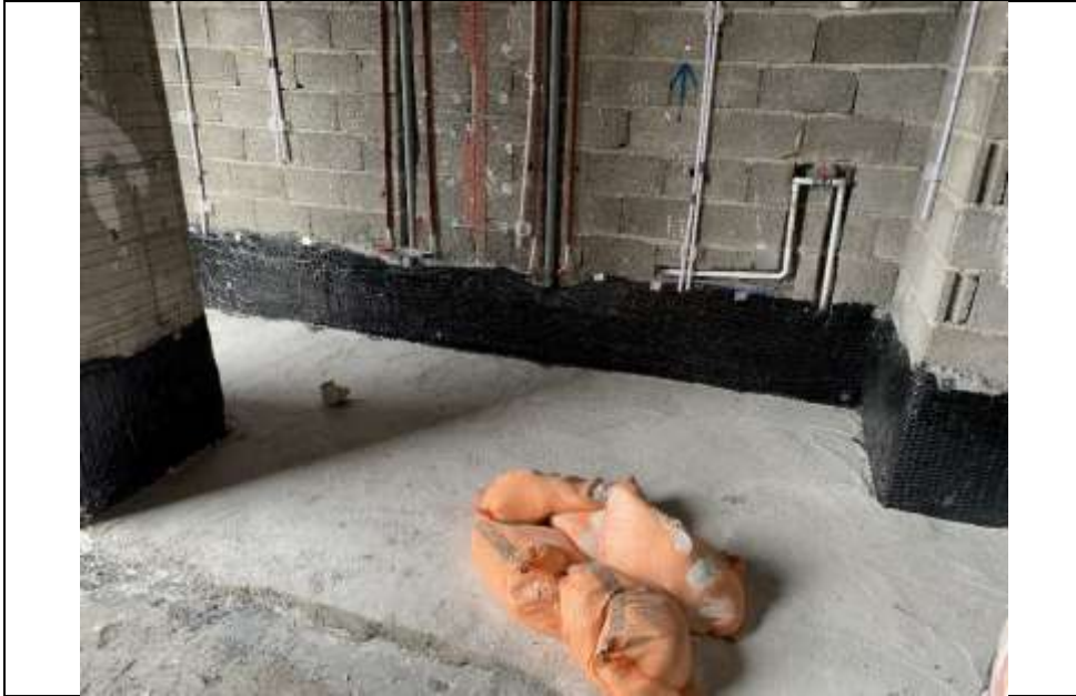
موضوع کاری: اجرای قیر و گونی (ایزولاسیون) آشپزخانه در طبقه اول بلوک B
