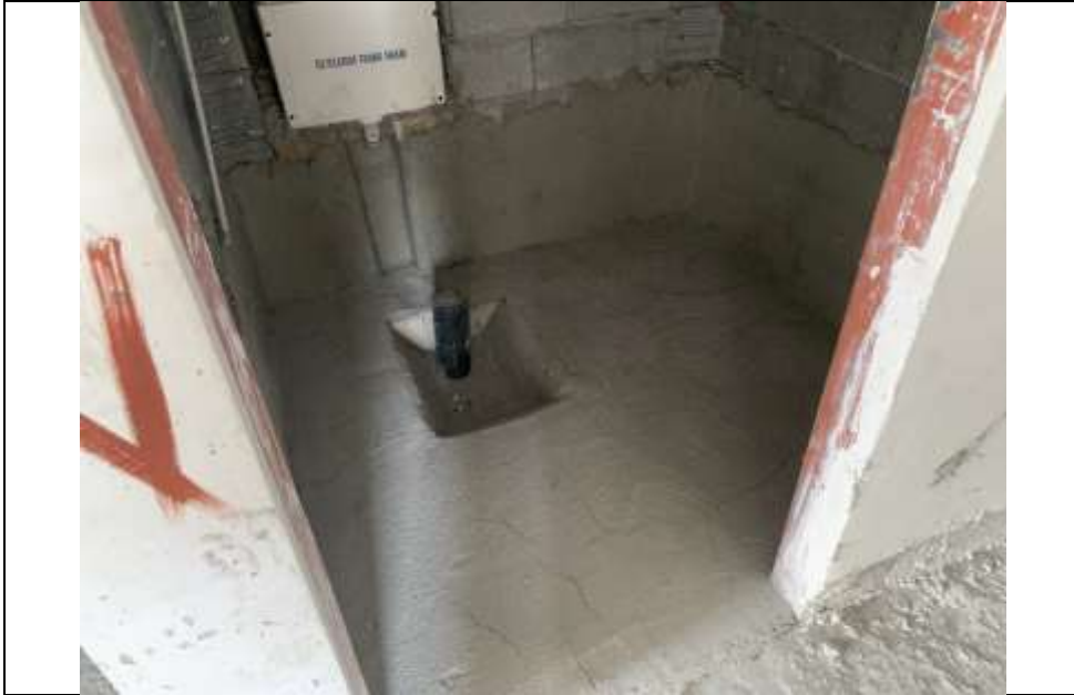
موضوع کاری: سیمان کاری (زیر سازی عایق) در طبقه اول بلوک B
