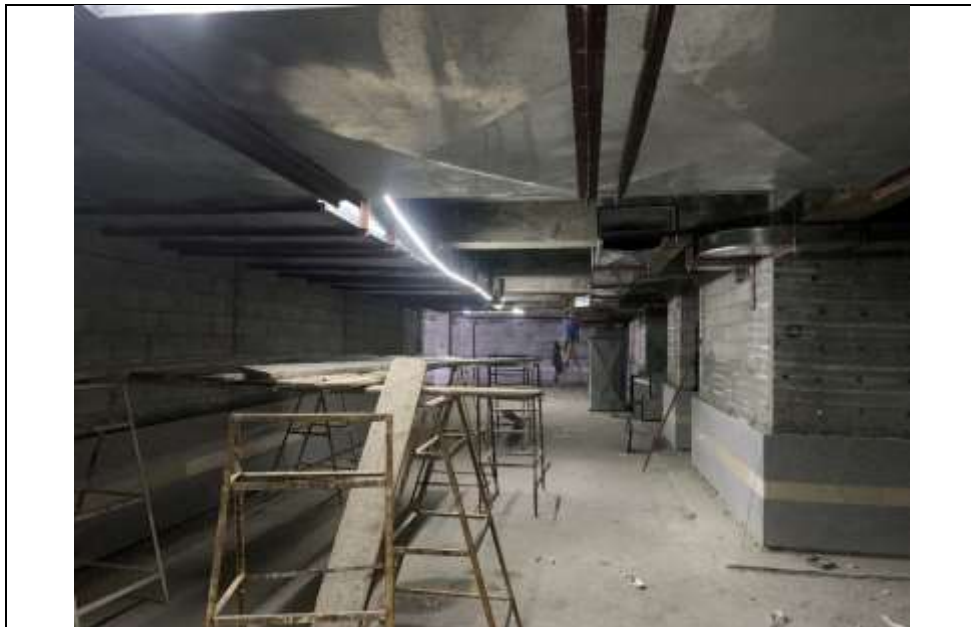
موضوع کاری: نصب کانال در طبقه 3-
