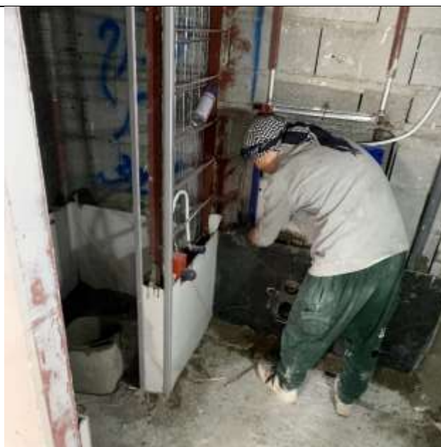
موضوع کاری: اجرای کاشی در طبقه اول بلوک B
