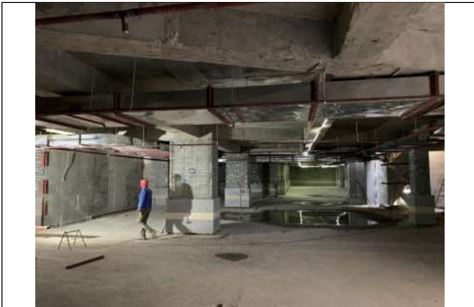
موضوع کاری: اجرای لوله اسپرینگلر و نصب کانال در طبقه 3-
