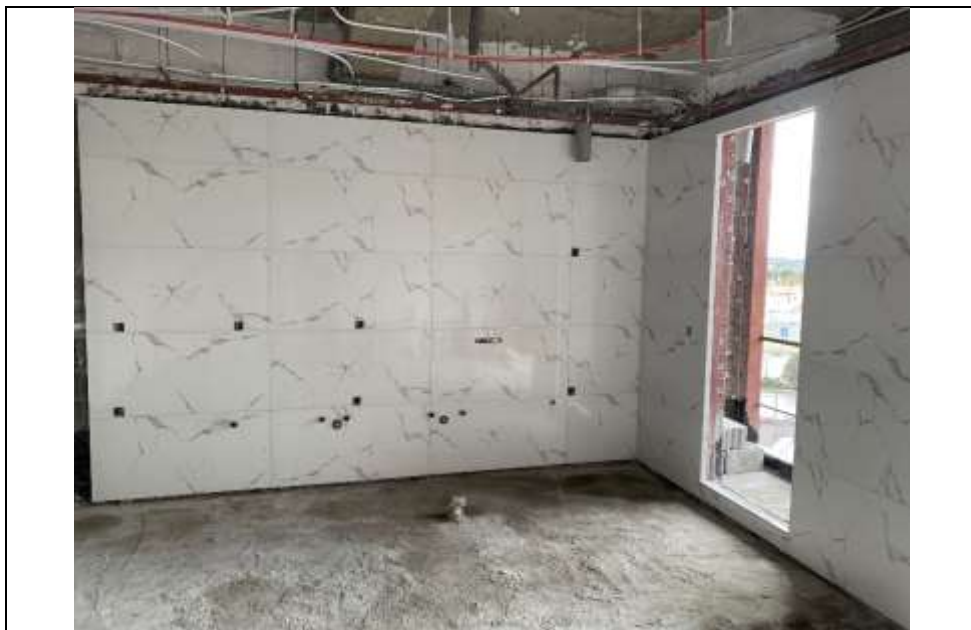
موضوع کاری: اجرای کاشی آشپزخانه
