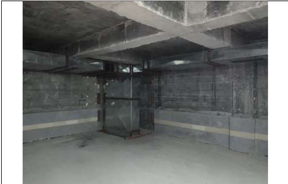
موضوع کاری: رایزر و کانال زیر سقفی اجرا شده در زیر زمین ها
