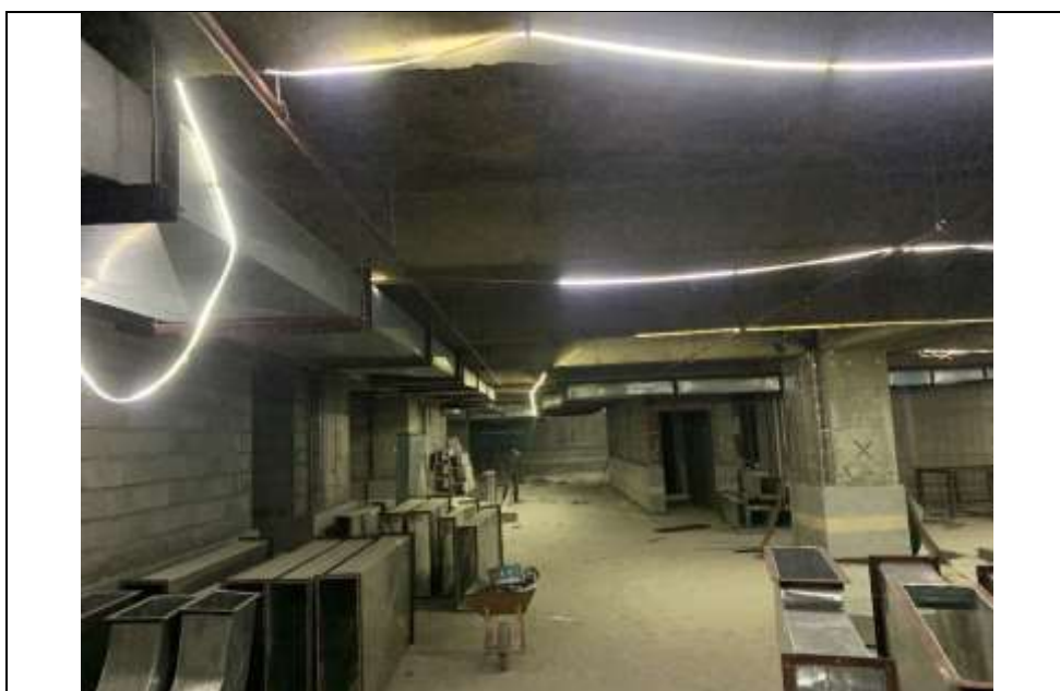
موضوع کاری: اجرای کانال در طبقه 4-
