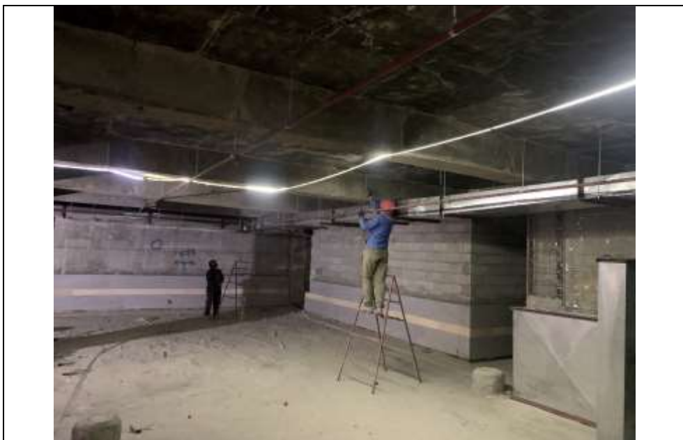
موضوع کاری: اجرای کانال در طبقه 4-
