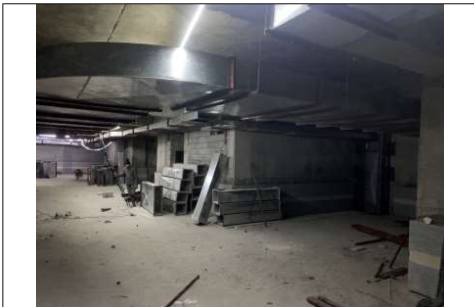
موضوع کاری: اجرای کانال در طبقه 4-
