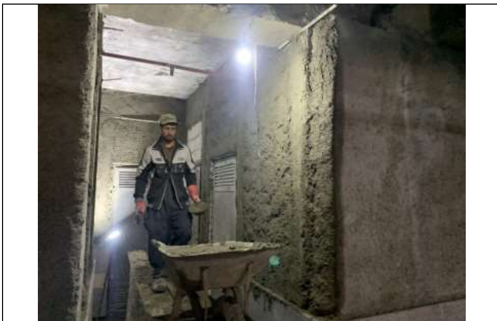
موضوع کاری: سیمانکاری طبقه 3-
