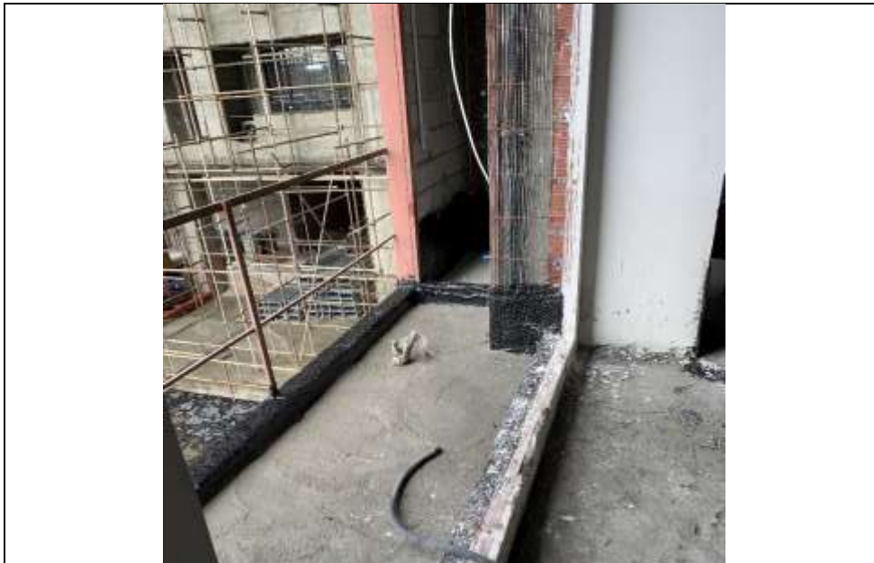
موضوع کاری: اجرای قیر و گونی (ایزولاسیون) بالکن ها در طبقه اول بلوک B
