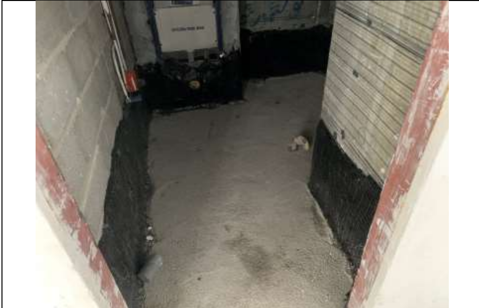
موضوع کاری: اجرای قیر و گونی (ایزولاسیون) حمام ها در طبقه اول بلوک B
