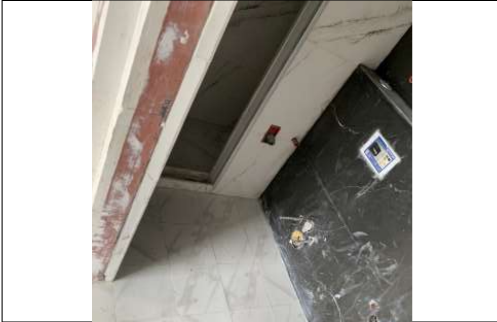
موضوع کاری: اجرای کاشی دیوار و کف حمام
