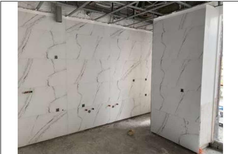
موضوع کاری: اجرای کاشی آشپزخانه
